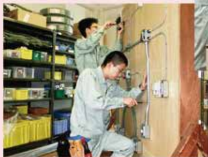
電気工事実習
